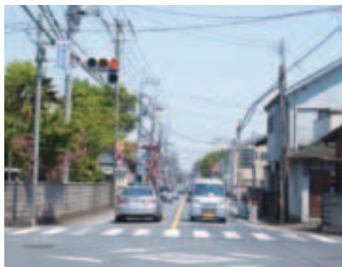
車線改良と歩道整備の要望がある大和田中町交差点
