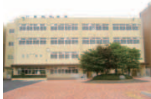
国の補助金を活用して改修を行った第四中学校
