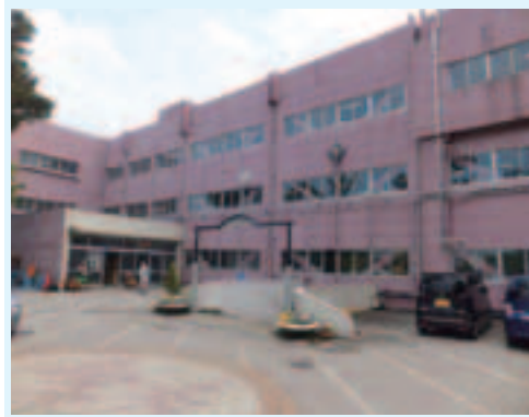
校舎大規模改修工事が行われる新座中学校
