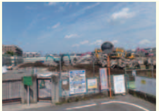
■解体工事が進む旧新座小学校跡地 (5月1日撮影)
