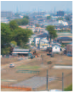
■工事が進む新座駅北口土地区画整理事業の様子
