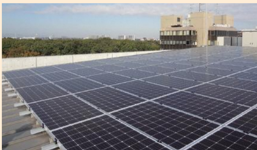
▲屋上の太陽光発電設備
