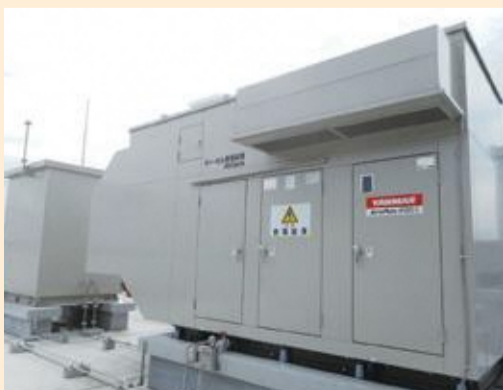
▲非常用発電設備
