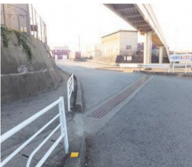
歩道整備の要望があるJR貨物ターミナル前
