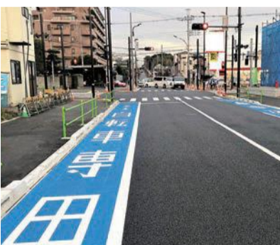
東久留米志木線の東久留米市側に整備されている自転車レーン
