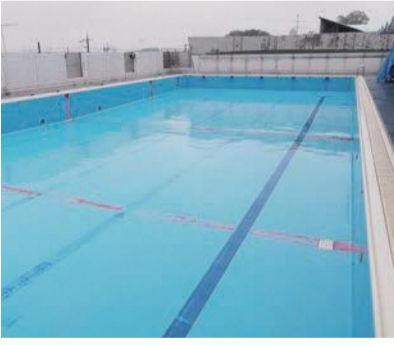
統廃合して屋内型とする提案があった学校のプール
