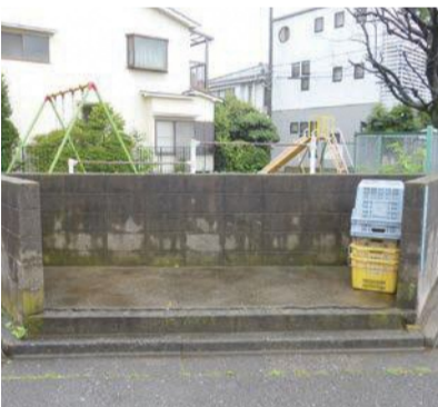
公園内に設置されたごみ置場
