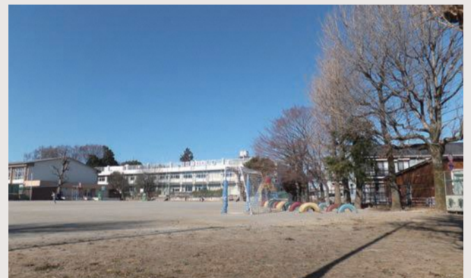
■台風で被害を受けた小・中学校の維持補修やブロック塀の改修等を行うもの
