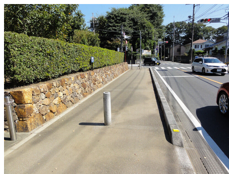
歩道段差の切り下げ(陣屋通り)
