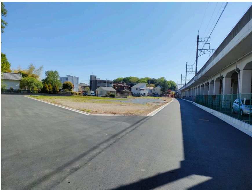
新座駅北口地区内で施工済みの区画道路 区6-38及び区6-40号線
