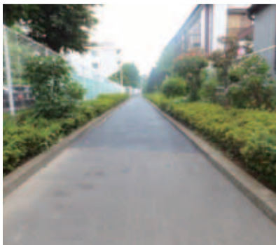
舗装の打換え工事が完了した野火止用水跡の道路
