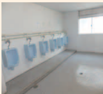
大規模改修工事前の第二中学校の男子用トイレ
