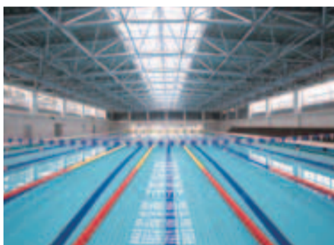
■10月から市民利用が開始される立教新座キャンパスに完成した室内温水プール
