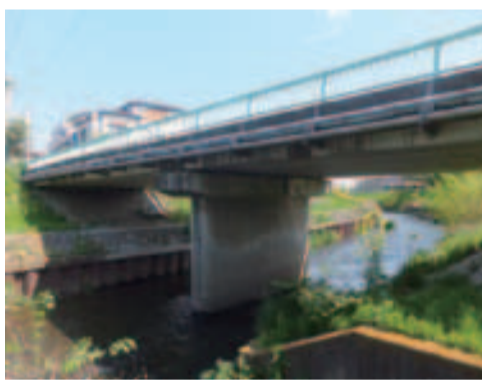
■橋の耐震改修工事が予定されている貝沼橋
