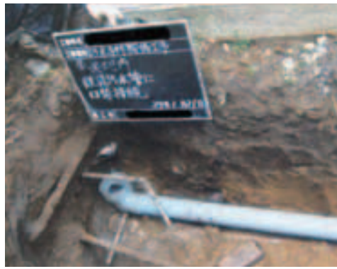
宅地内公共下水道工事の様子
