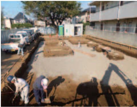
■建設工が進む(仮称) 東三丁目集会所
