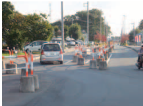
東久留米・志木線と水道道路との交差点の現在の様子
