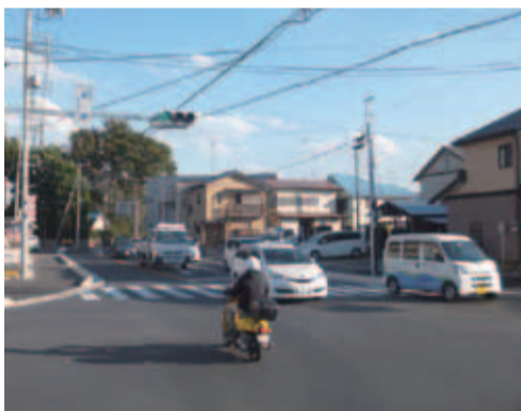
改良工事が進む栗原交差点
