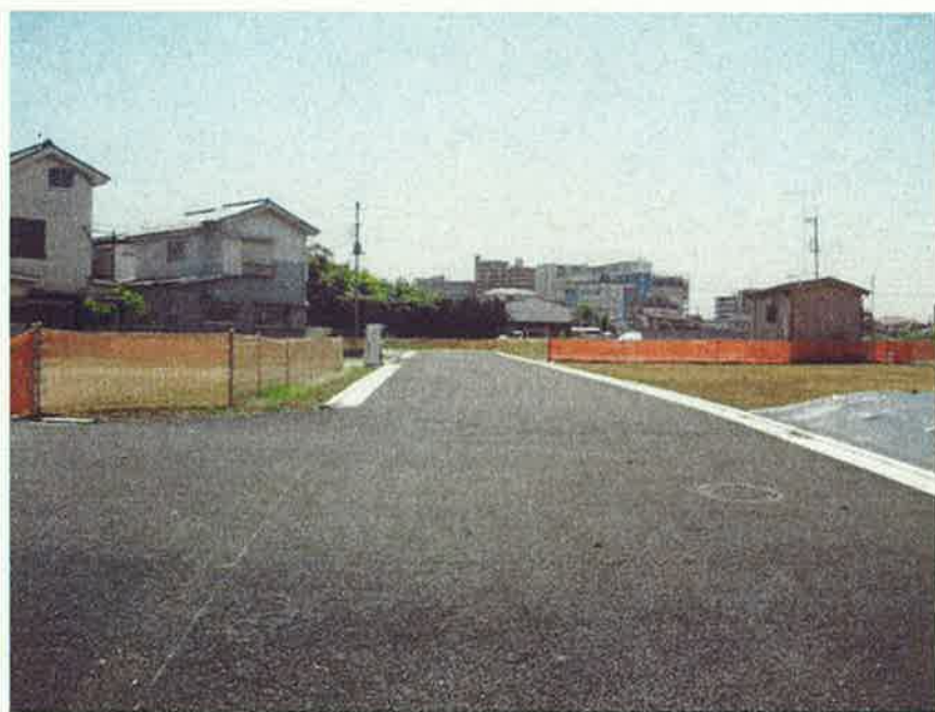
区6-22号線 道路築造等工事 施工済状況写真
