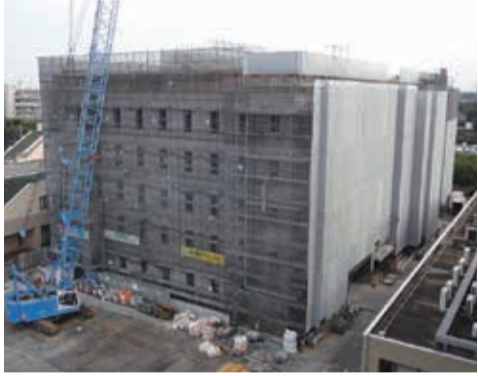
現在建設中の市役所新庁舎
