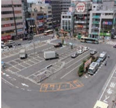
■整備工事が始まる志木駅南口駅前広場
