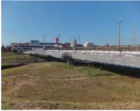
耐震補強工事中の柳瀬川ふれあい橋
