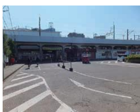
大屋根設置の要望がある新座駅北口
