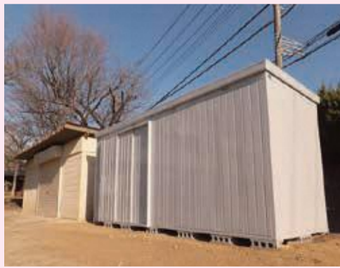
■新設された栄小学校の体育倉庫
