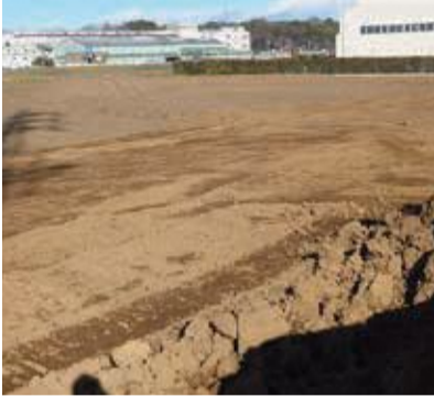
大和田少年サッカー場建設予定地
