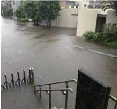
内水氾濫の被害があった東北二丁目
