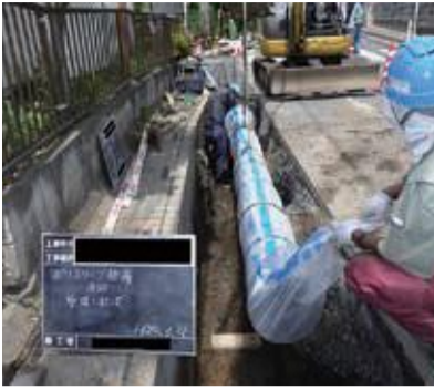
水道管の布設替え工事の様子
