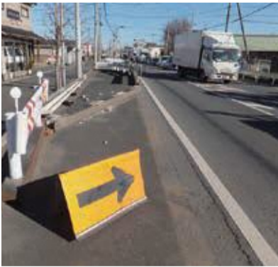
抜本的な安全対策の要望がある志木街道
