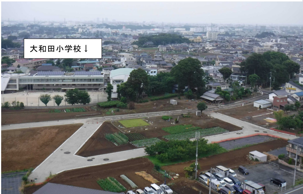
■ 区8-7、8-8、8-9号線 道路築造等工事 施工状況写真
