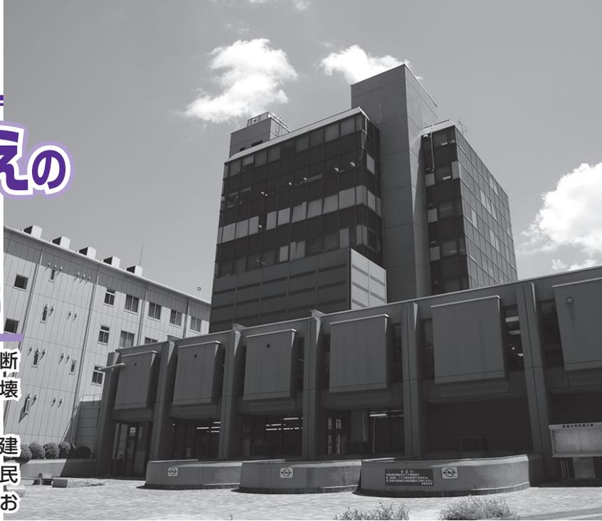
新座市役所本庁舎は、平成23年度に実施した耐震診断により、震度6強から7程度の規模の地震で倒壊又は崩壊する危険性があることが判明しました。
