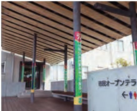
▲市役所オープンテラス 柱巻き
