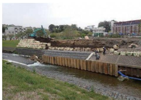
台風19号により護岸崩壊した黒目川の災害復旧工事(堀ノ内一丁目地内)
