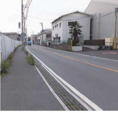
拡幅が望まれる水道道路の歩道
