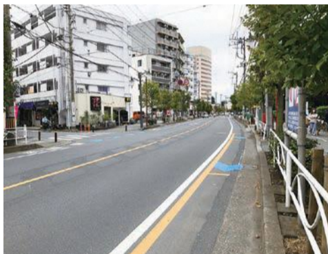
道路照明灯が落下した新座中央通り
