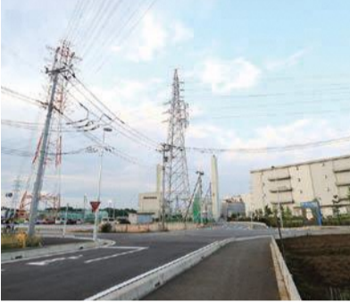
信号機が設置されていない大和田・坂之下橋付近の交差点
