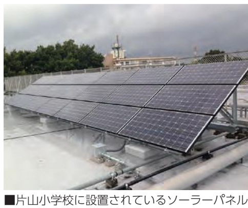
片山小学校に設置されているソーラーパネル
