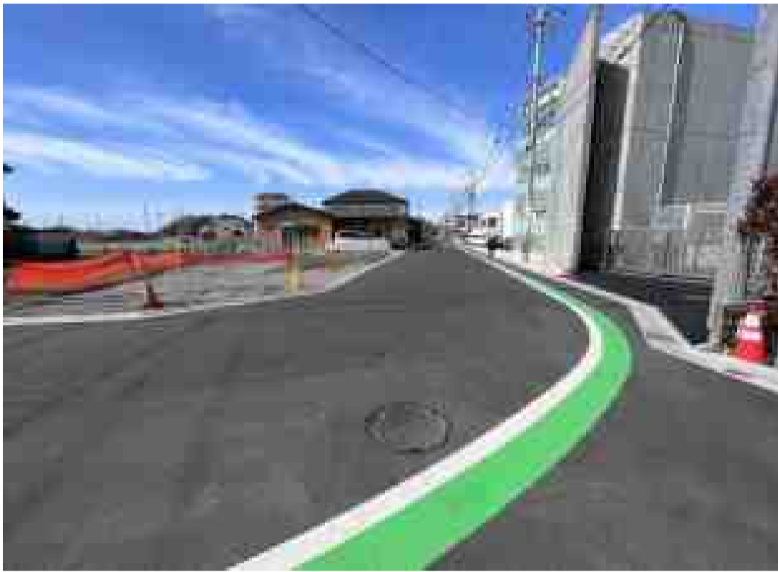
区8-4号線 道路築造完成写真
