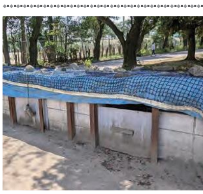
栄庭球場維持管理のための土や砂の保管庫
