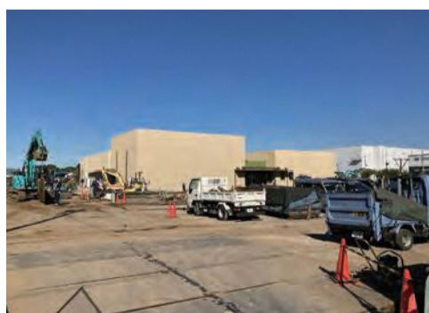
建設中の(仮称)保健センター・歴史民俗資料館複合施設
