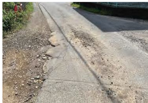
市道第3074号線(菅沢二丁目地内)の舗装状況
