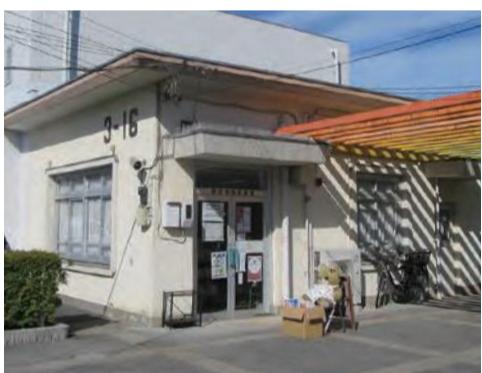
新座団地図書室外観
