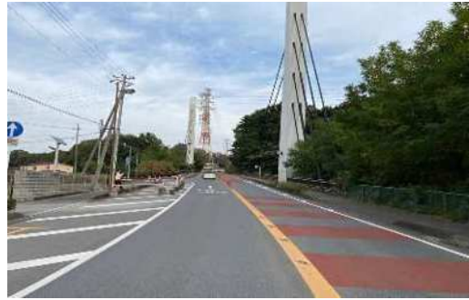
地区幹線道路（市道9号線）
