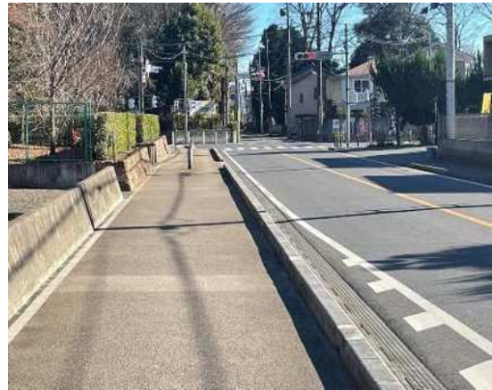
歩行者の安全を確保した歩道整備
