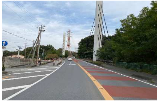
地区幹線道路（市道第9号線）
