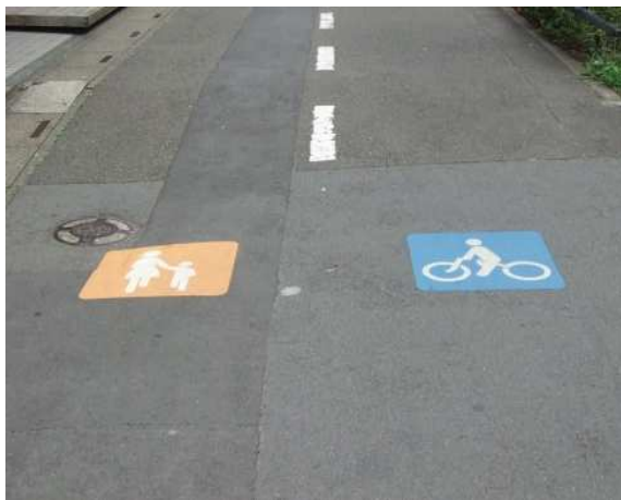
ユニバーサルデザインに配慮した路面標示
