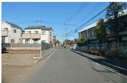
補助幹線道路（市道第123号線）
