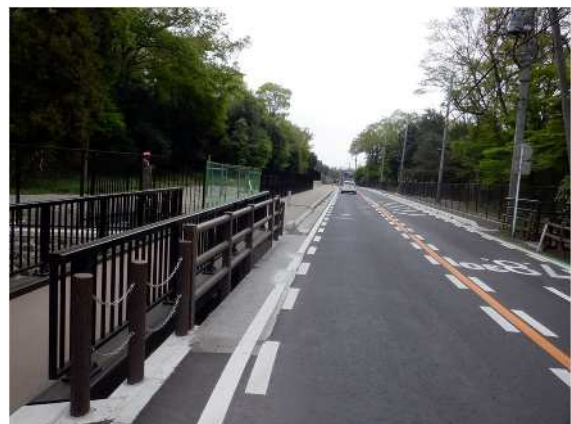
市道第8号線(陣屋通り)
