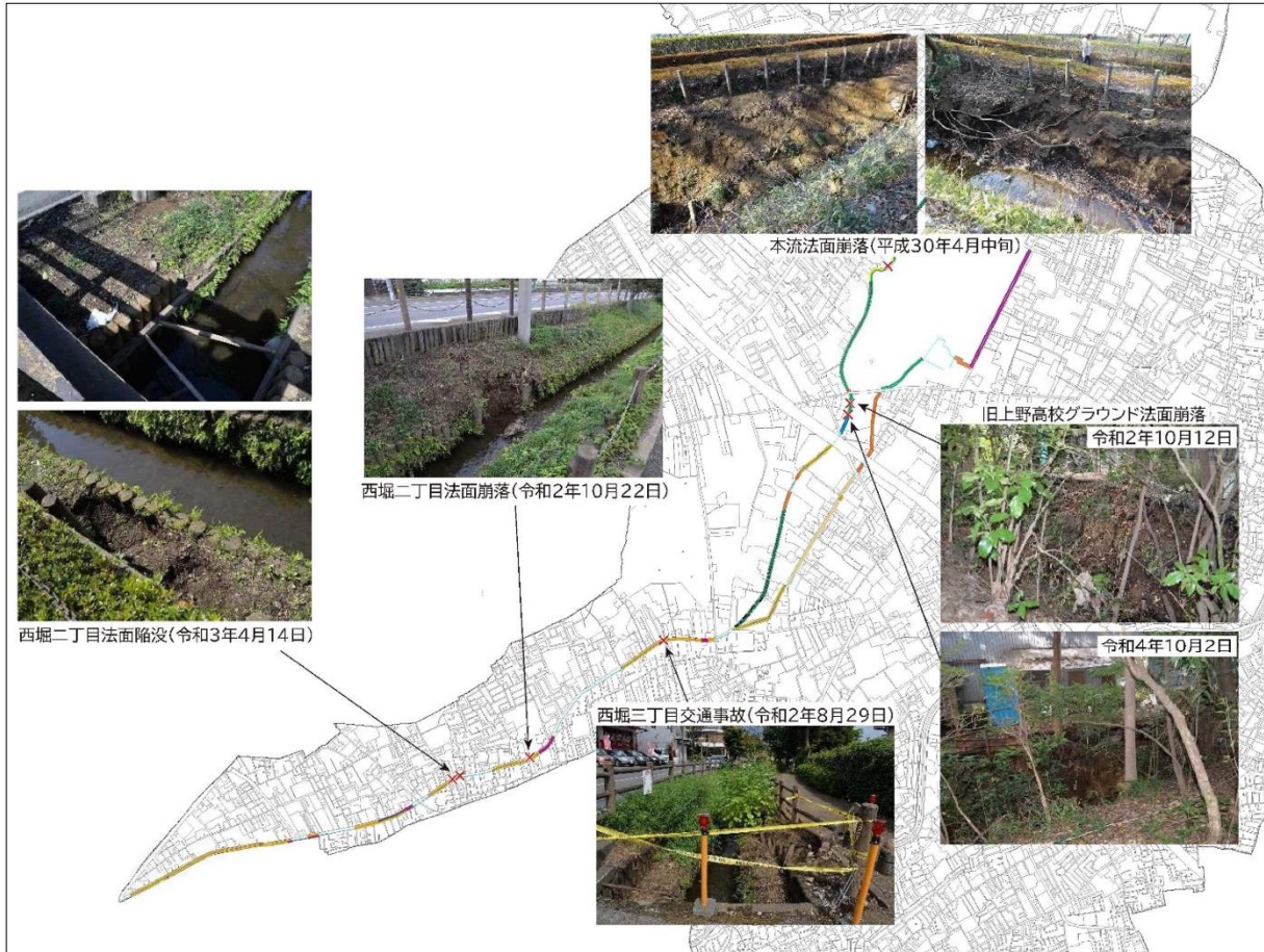
図 48：崩落危険箇所と近年のき損箇所
