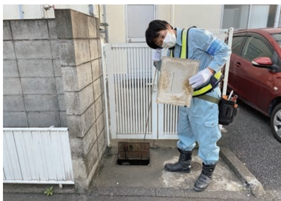
漏水調査の様子
