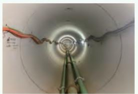
県道下の地中を約314m掘り進み、既設マンホールへ到達させ完成
