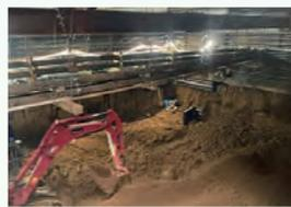
資機材の搬出入口になる縦穴を造る（およそ縦8m、横7m、深さ6m）
