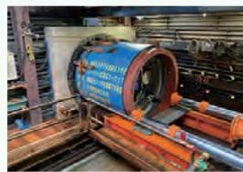
先端に掘削機を取り付け、地中を掘削しつつ、油圧ジャッキを使って管を押し込みながら埋設する
