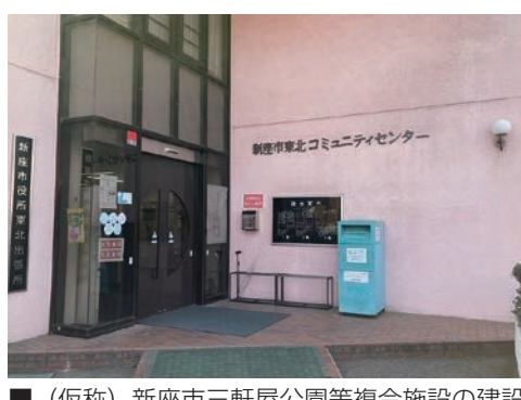
(仮称) 新座市三軒屋公園等複合施設の建設予定地 (東北コミュニティセンター)
