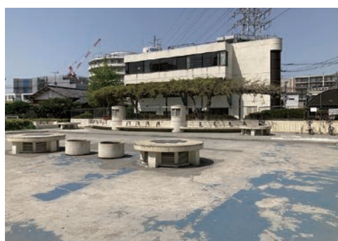
（仮称）新座市三軒屋公園等複合施設の建設予定地
