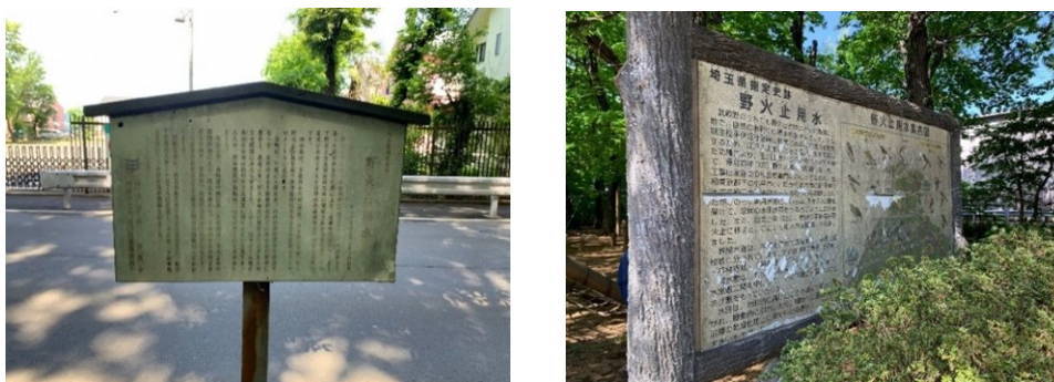
図 49：劣化の進んだ説明板
