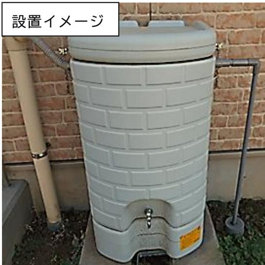
雨水貯留槽とは、建物の屋根に降った雨水を雨どいから貯める地上据え置き型のタンクのことです
