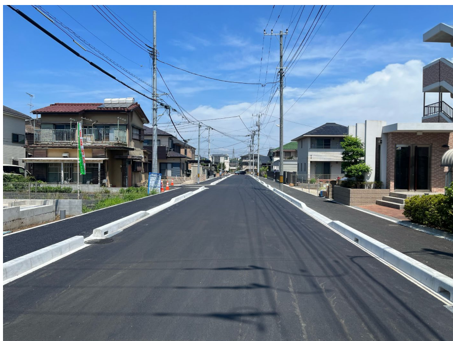
区10.5-1号線 道路築造完成写真
