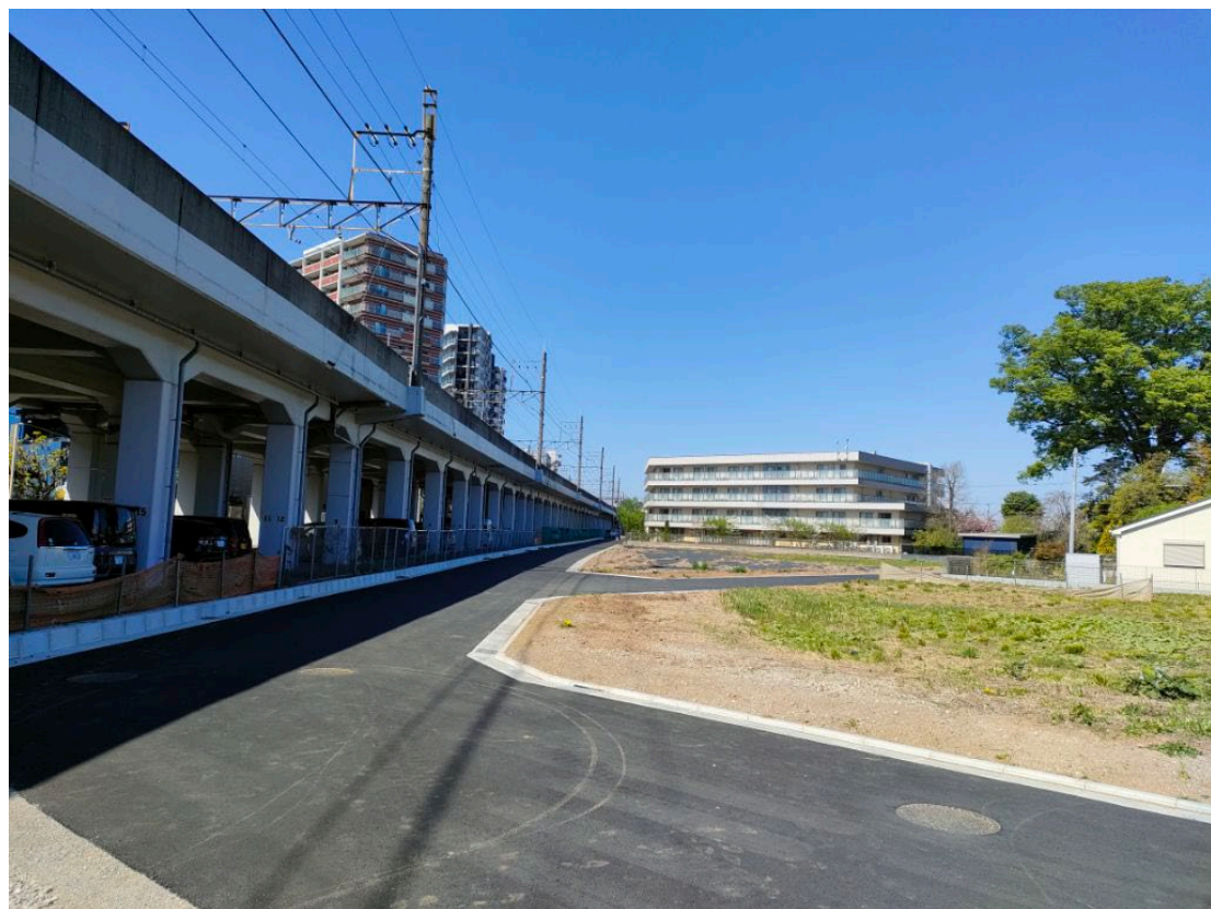
区6-38、39、40、41号線 道路築造完成写真
