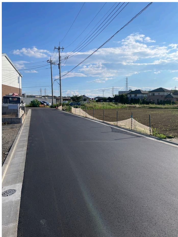
区6-33号線 道路築造完成写真
