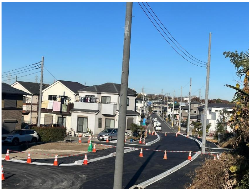
新座駅北口地区内で施工中の区画道路 区10.5-1号線（写真は令和6年度完成部分）
