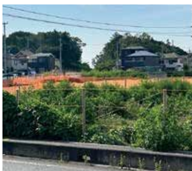
■水道道路と交差する新堀地区の放射7号線工事予定地
