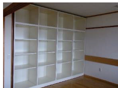
写真Ⅱ.49 可動式家具による間仕切り
