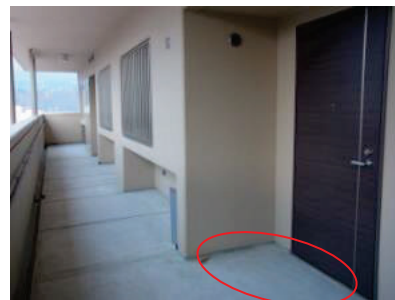
写真Ⅱ.65 アルコーブが設置された玄関前
