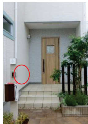
写真Ⅱ.13 敷地境界部分に設けられた 住宅内との通話機能を有する カメラ付きインターホン
