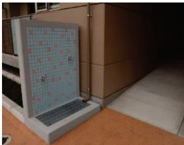
写真Ⅱ.89 住棟入口に設けられた手洗い場
