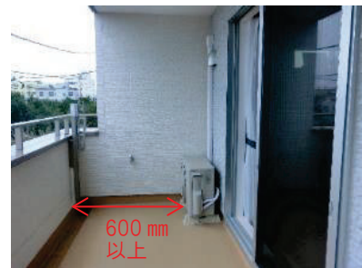
写真Ⅱ.54 手すりからの離隔距離を確保した 室外機置場
