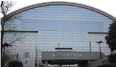
④ 市民総合体育館
