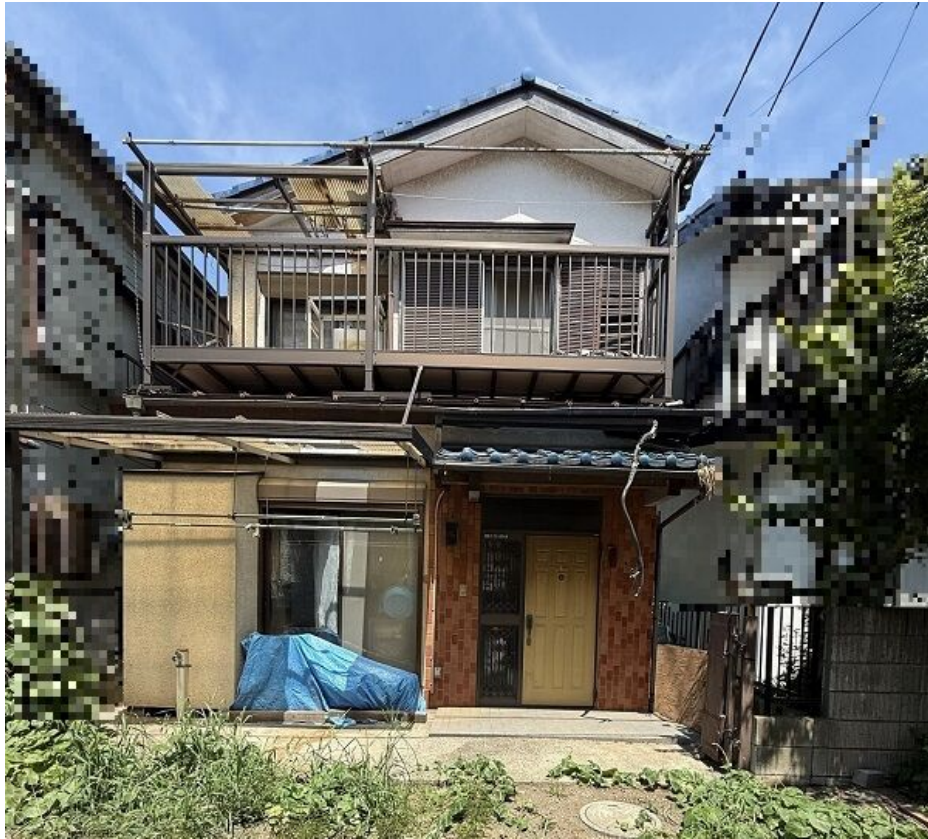
[写真①] ※ [建物 南西から]
