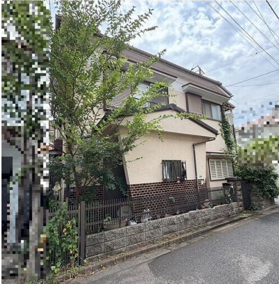
〔写真①〕 ※建物 北西から
