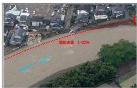
侵食により家屋が流失した状況
