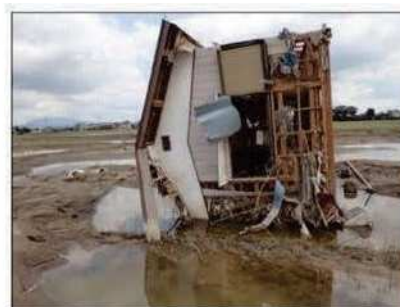
堤防決壊による家屋の倒壊
