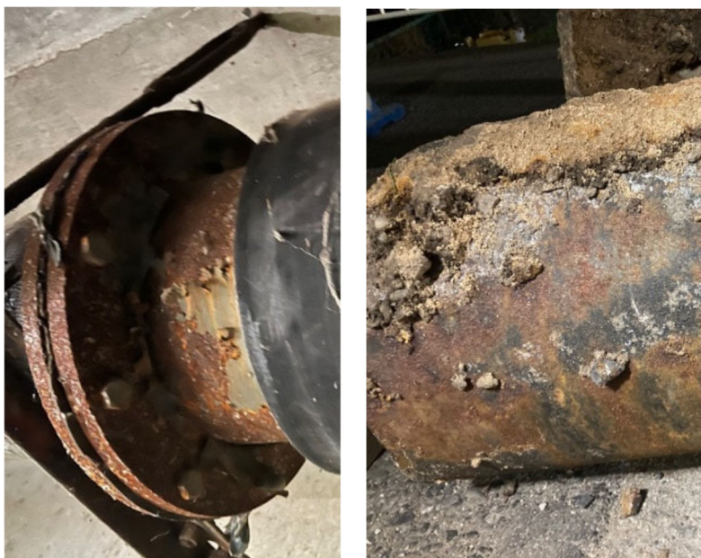
市内の老朽化した配水管（布設替え前の状況）
