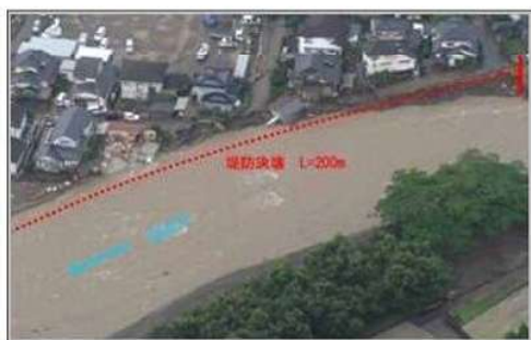
侵食により家屋が流失した状況
