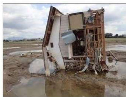
堤防決壊による家屋の倒壊
