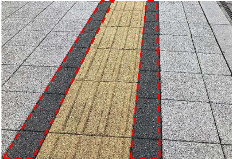
写真 2-7-3 周辺の舗装材を変更した視覚障害者誘導用ブロック
