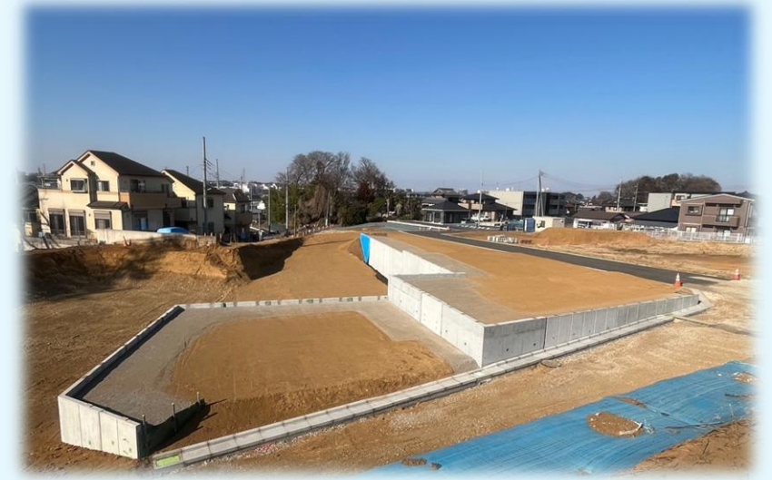
34街区 擁壁整備と道路築造の様子 (道路は現在施工中)
