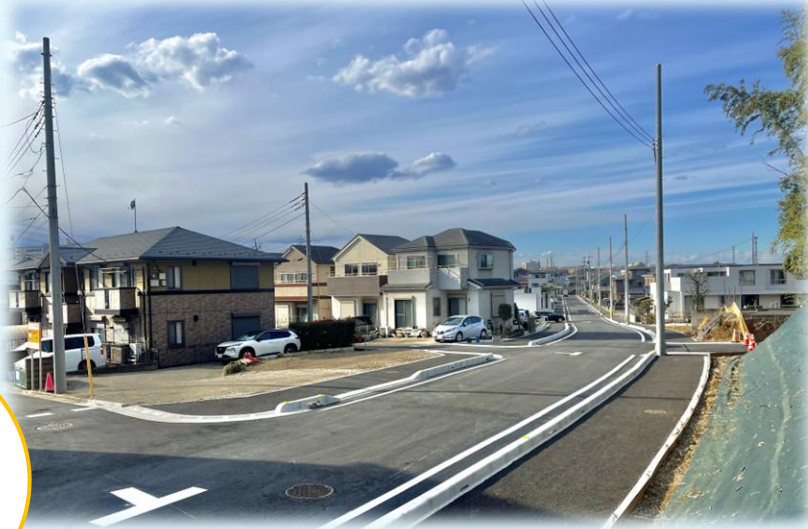
区10.5-1号線 (令和6年度に路線全体の約半分が竣工)
