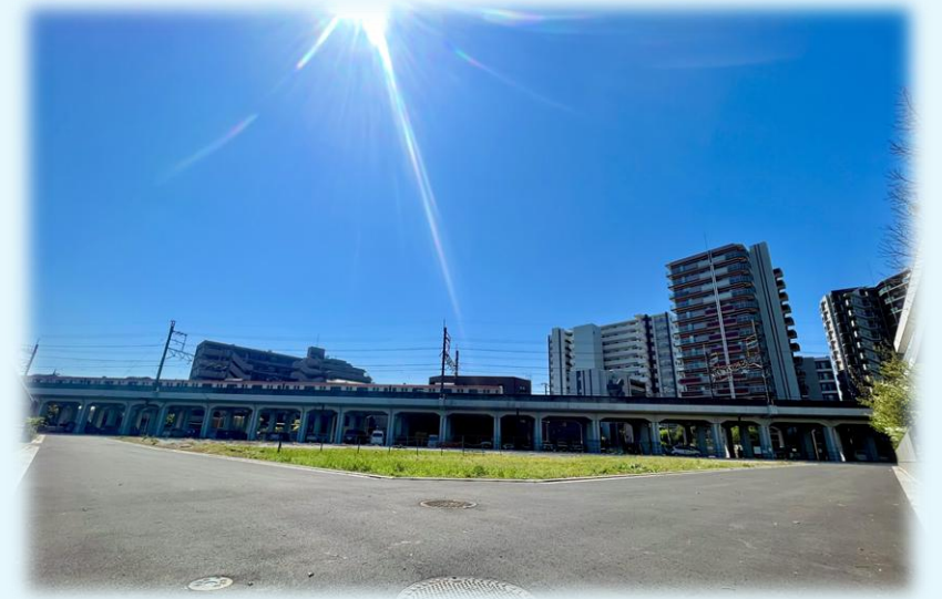
区6-39号線(左) 区6-38号線(右) (令和4年度竣工)
