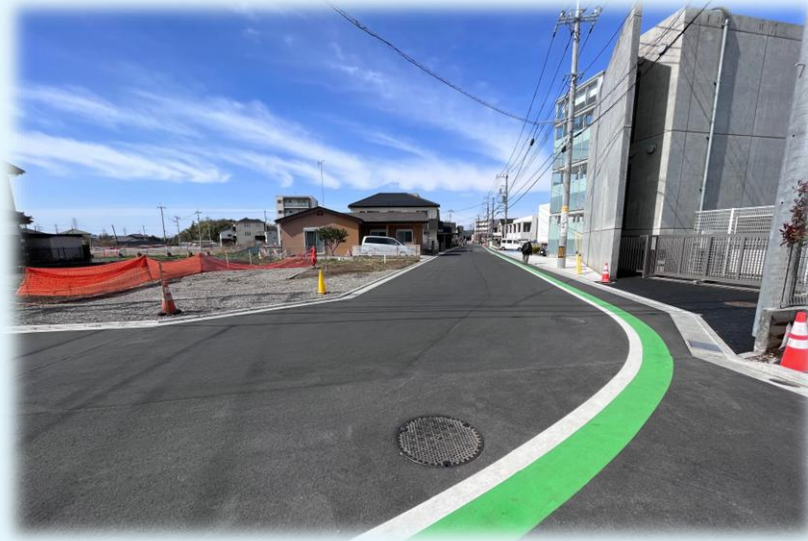
区8-4号線 (令和3年度竣工)
