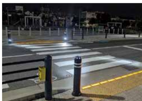
埋込型信号機 (写真は大阪府守口市の道路に設置されているもの)
