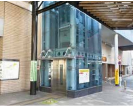
志木駅南口エレベーター
