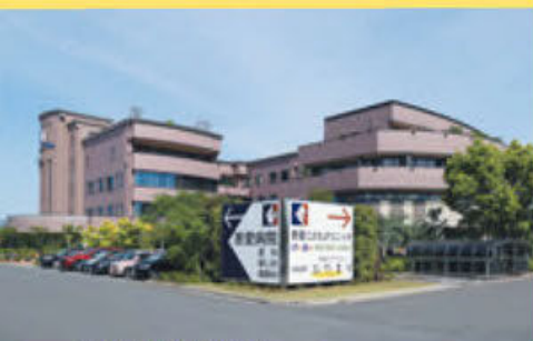
恵愛病院全景/駐車場250台
