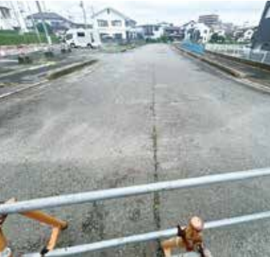
北野二丁目の貯留施設整備予定地
