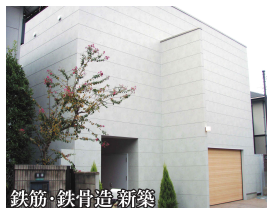
鉄筋・鉄骨造新築
