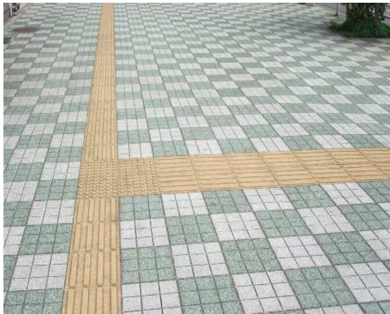
視覚障がい者誘導用点字ブロックの設置
