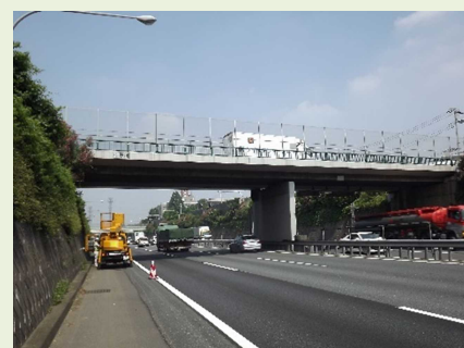
関越自動車道に架かる橋
