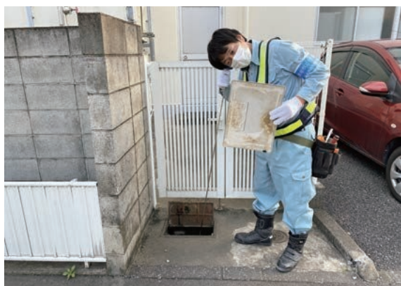
漏水調査の様子
