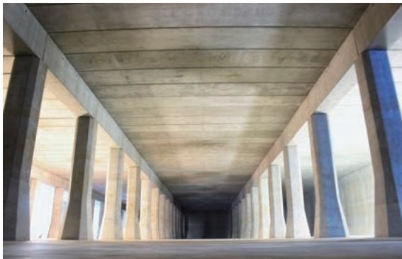
大和田三丁目地下調整池
